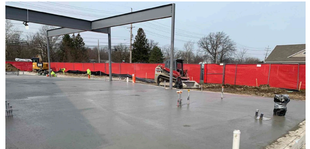
North addition slab pour
